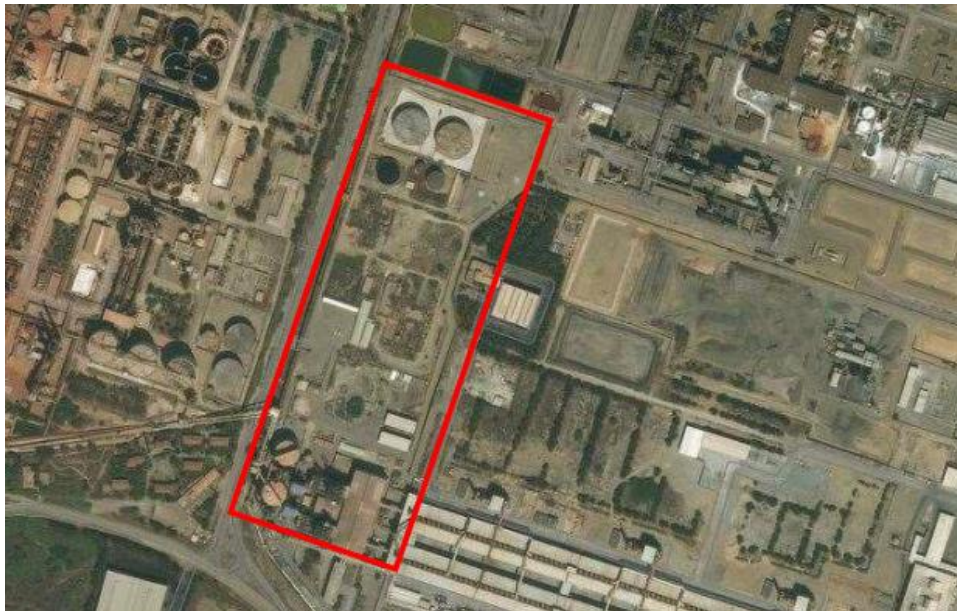
Figura 2 Vista aerea Centrale Termoelettrica di Portoscuso
